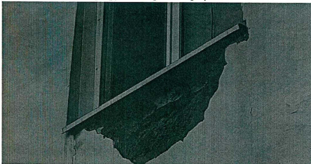
Фото №6 Фрагмент разрушения фасада при установке окна.
